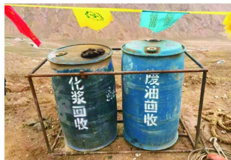
图6 施工中的液体垃圾回收装置
