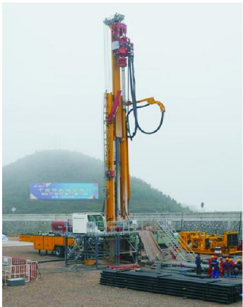
图4 宝峨 RBT-100 型全液压力头钻机 (在贵州省地矿局 111 地质队地热井施工现场)
