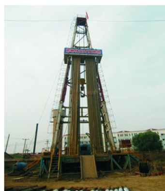
图3 地热井施工中的散装转盘钻机应用现场
