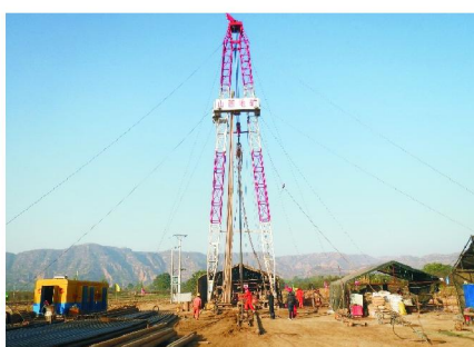
图2 地热井气举反循环钻进施工现场
