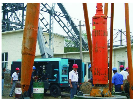
图1 地热井气动潜孔锤钻进施工现场
