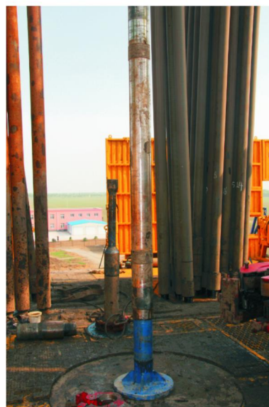
图1 YZX178型液动潜孔锤在“松科二井”钻井现场
