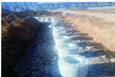
图6 管桩线状排列图
