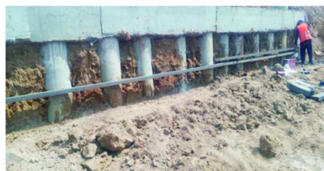
图7 施工完成的现场图
