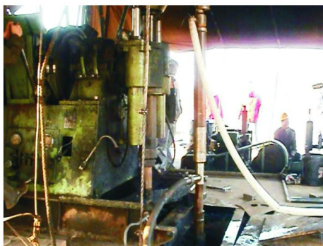
图8 起拔器现场工作状态图
