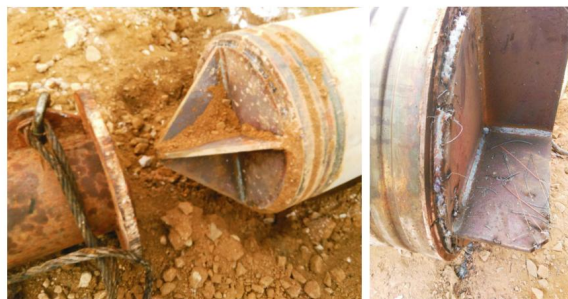
图2 管桩桩尖的改进
