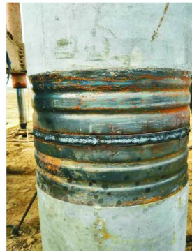
图3 管桩接桩
