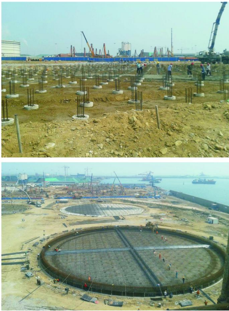
图5 管桩后期施工
