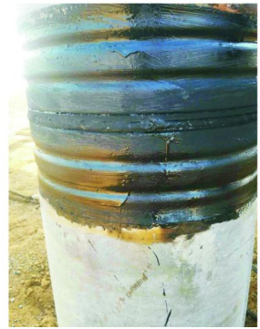
图4 管桩接头防腐处理
