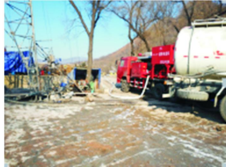
图 6 固井车在现场施工作业
