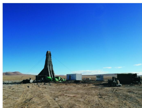
图 5 调查井施工现场
