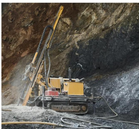
图6 湘西保靖矿山潜孔锤施工
