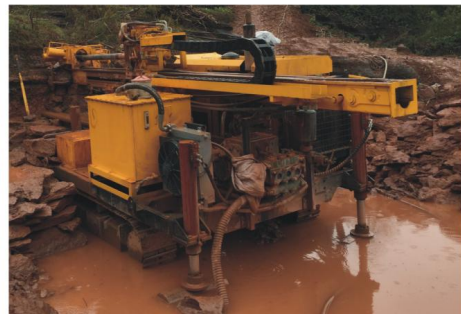
图5 湘西永顺溶洞引水工程施工
