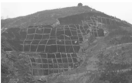
图 3 生态袋砌筑完成后
