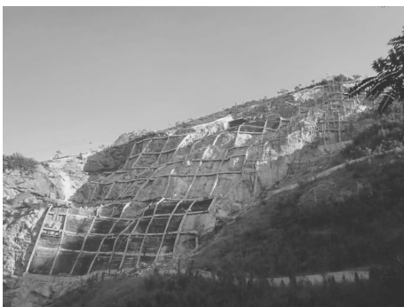
图2 格构梁施工结束后
