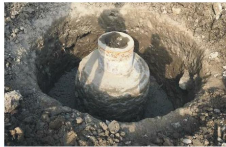
图 4 试验桩成桩
