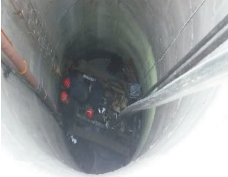
图4 辐射井井内施工照片
