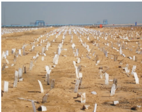
图 7 塑料排水板施工情况
