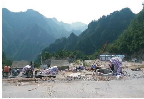
图10 城门峒1号副坝辐射井施工现场
