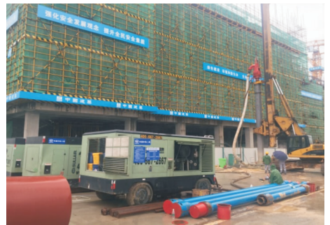
(a) 施工现场
