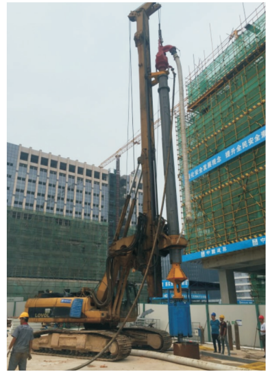
图 3 气动潜孔锤反循环钻具现场连接
