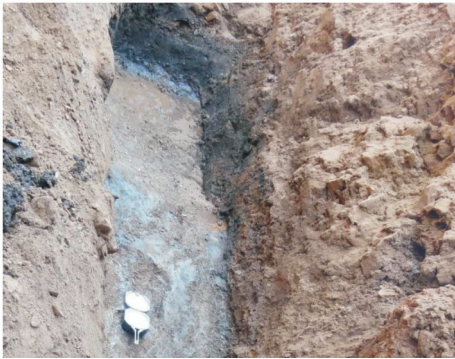
图 3 坡体槽探确定滑面
