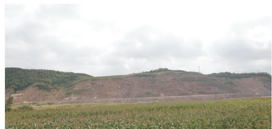
图 1 岫岩县小虎岭社区口子街老山头边坡全貌
