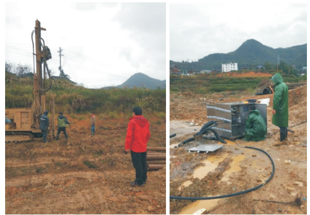
(a) 气动潜孔锤钻机施工
