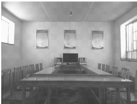
图2 改善后:将会议室重新刷墙、吊顶。党建等各项规章制度上墙,办公座椅摆放整齐,配备流动书箱。作为会议室兼党小组活动室
