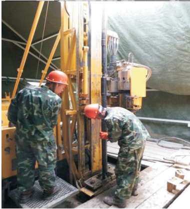
图10 阳山金矿区 ZK0112 孔现场纠斜试验
