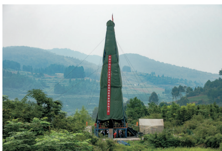
图 1 湘永地 1 井钻探施工现场
