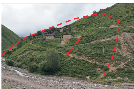
图 3 甲热滑坡全貌
