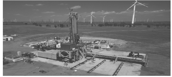
图 1 CMD180T 型钻机及 DR1 井施工现场全貌
