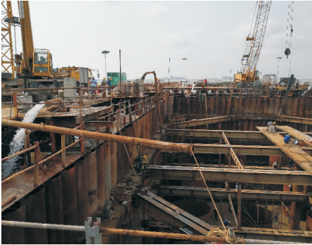
图 6 承压水位降至封底顶面以下后围堰内排水
