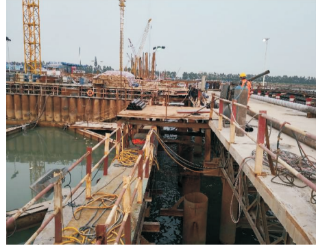
图3 突涌发生后围堰内回灌水
