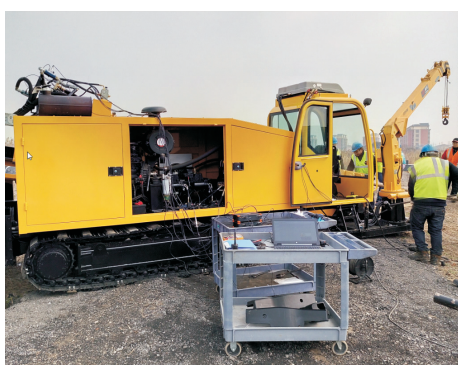
图 6 测试现场 Fig.6 Testing site
