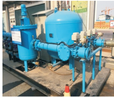
图5 全自动清洗过滤器 Fig.5 Fully automatic cleaning filter
