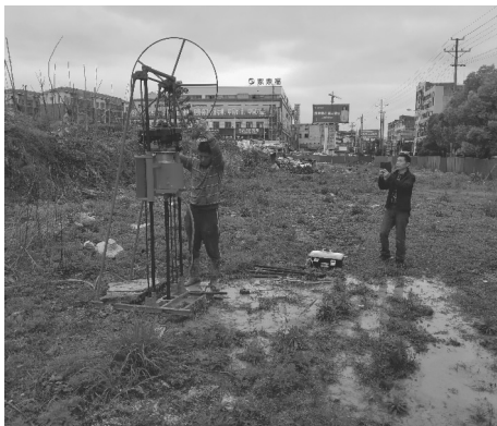
图 9 地基勘察孔施工现场
