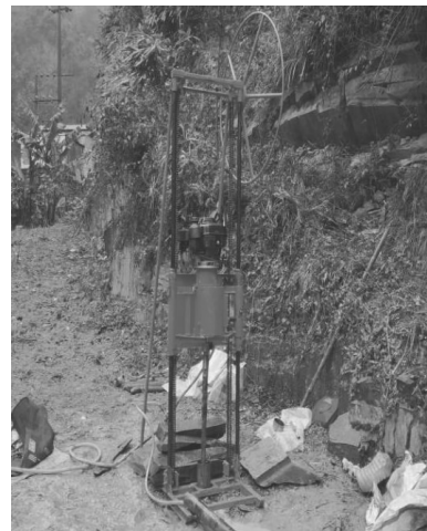
图7 水坝勘测孔施工现场
