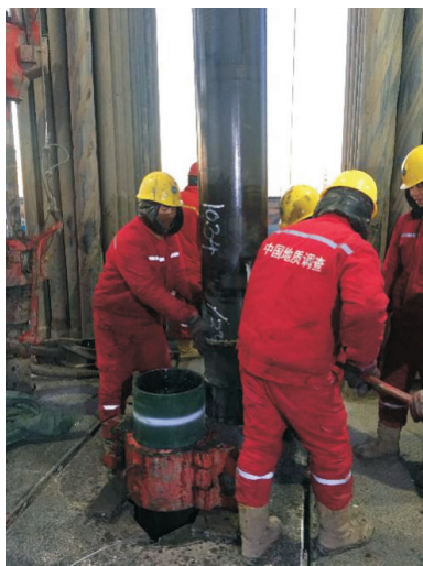
图 3 CGSD-01 井一开下套管
