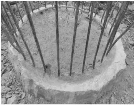
图 2 钢筋笼位移
