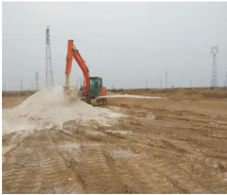
图3 灰土垫层施工
