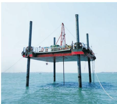
图 17 多功能地质勘察平台施工现场
