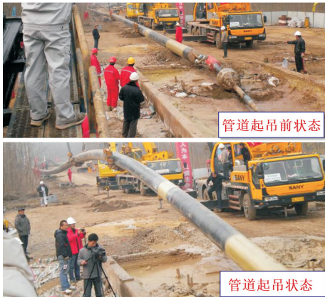
图1 管道起吊施工图
