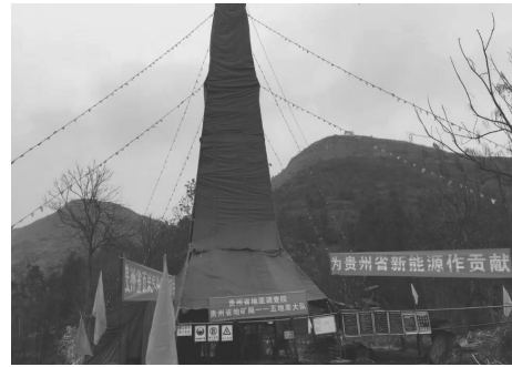
图1 黔普地1井施工现场
