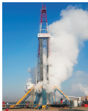
图3 压缩空气洗井
