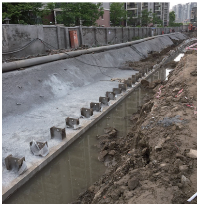
图 8 SMW 工法桩及冠梁完成后效果
