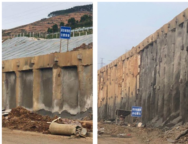
图 5 支护结构施工后效果
