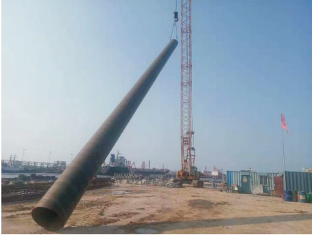
图4 吊放钢护筒
