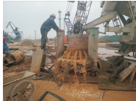
图7 混凝土开盘浇注
