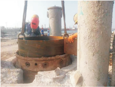
图5 固定钢护筒
