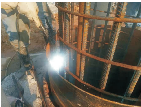
图6 安装到位的钢筋笼与钢护筒间固定
