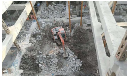
图 9 破掉盖板后的情况
