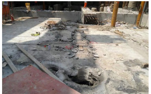
图 8 RJP 注浆完成后的情况
