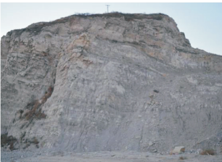
图 3 边坡东部治理前(镜像东北)
