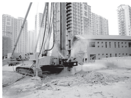
图 6 山东聊城旋喷搅拌施工现场 Fig.6 Jet grouting in Liaocheng, Shandong
