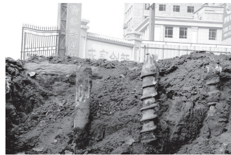
图4 工地现场挖出的螺杆桩
