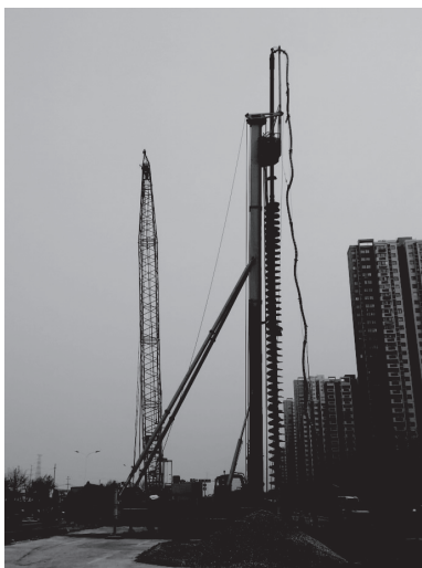
图 7 济南轨道交通 R1 线演马庄地铁站施工现场
