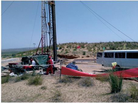
图1 宁东地区钻探施工现场地貌
