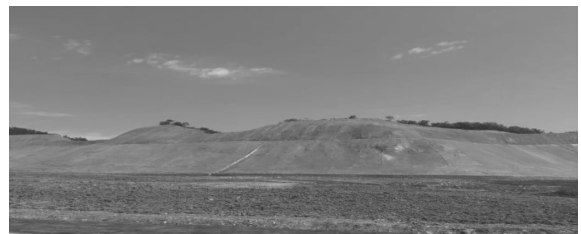
图5 施工后的项目区
