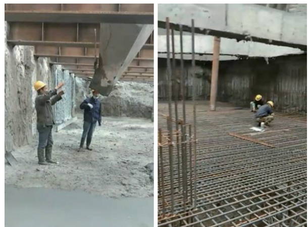
图 11 电梯井浇筑垫层、底板绑扎钢筋
