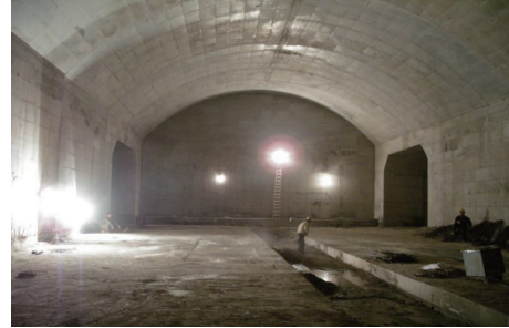
图6 隧道衬砌实际效果
