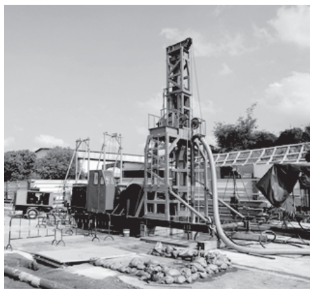
图 7 厦门施工现场
