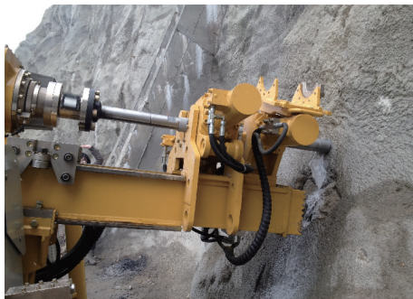
图 11 施工现场图片
