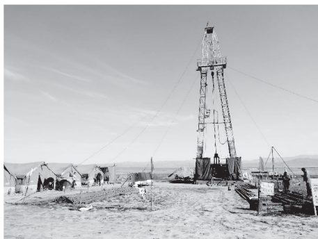
图 1 钻探施工现场 Fig.1 Drilling site
