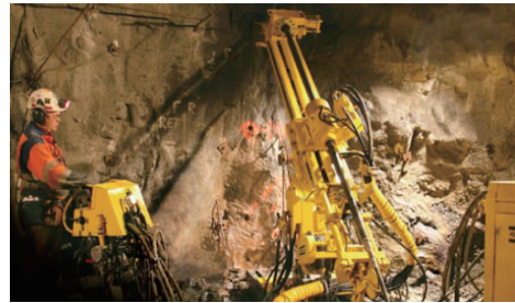
图 8 Diamec U6 钻机 Fig.8 Diamec U6 drill rig
