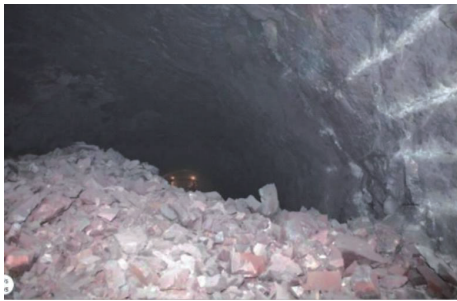
图2 静态破碎法破岩效果
