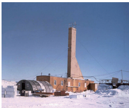
图3 东方站5G钻孔地表钻探设施 [5]
