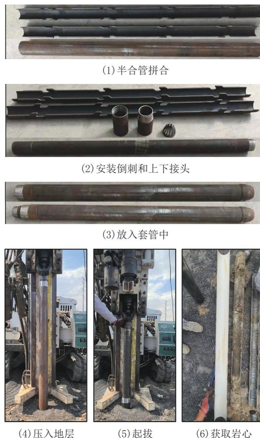
图4 施工工艺流程
