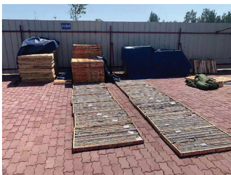
图3 施工现场铺设面包砖
