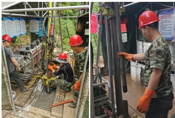
图4 钻机作业现场
