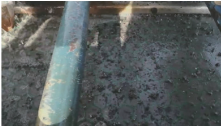
图5 气举反循环钻进正常返水(渣)情况
